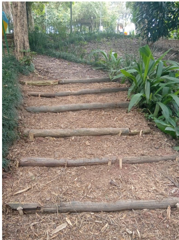
Figura 7: Adequação de escadas
